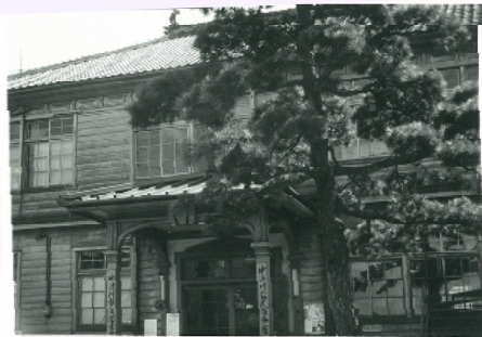
元郡役所 (現公民館)
