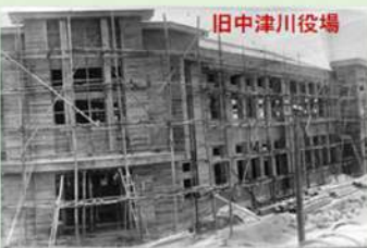
昭和9年 えびす町 旧中津川役場
